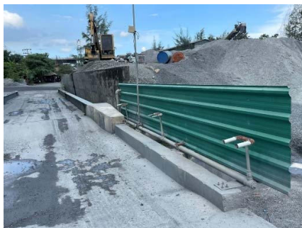
รูปที่ 2-21: ระบบฉีดล้างล้อรถบรรทุก
